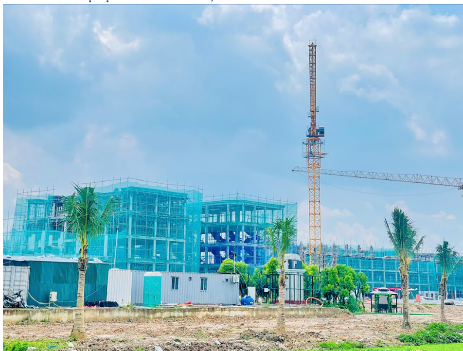
Hình 10: Tiến độ dự án Golden Tower, PC1
